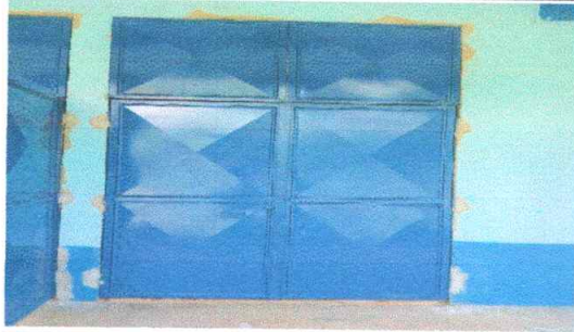
Foto 1: Se evidencia la instalacion de puertas de aulas.
