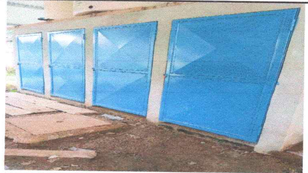
Foto 4: Muestra la instalacion de puertas para 4 baños.
