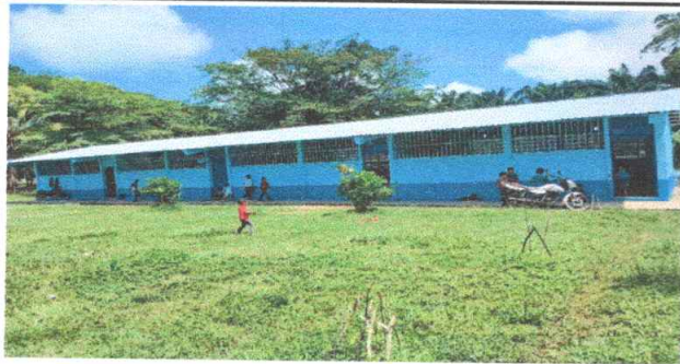
Foto 3: En esta fotografía demuestra el avance de un 100% del remozamiento desarrollado.
